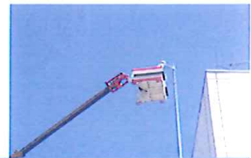
100m観音像リニューアル 100m作業 300Tクレーン
